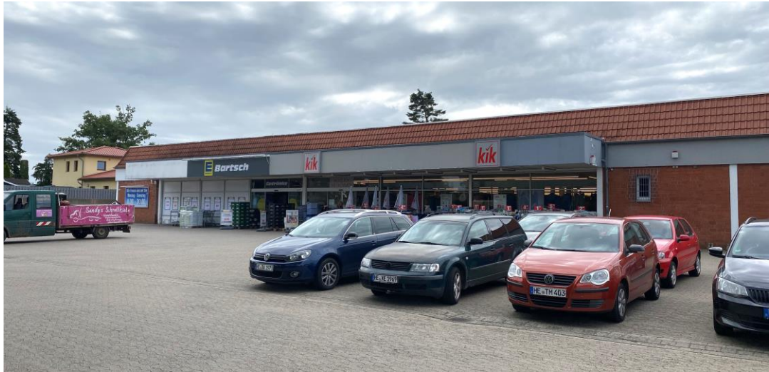
Abbildung 14: Verbundstandort von Kik und Edeka-Getränke in der Campenstraße
