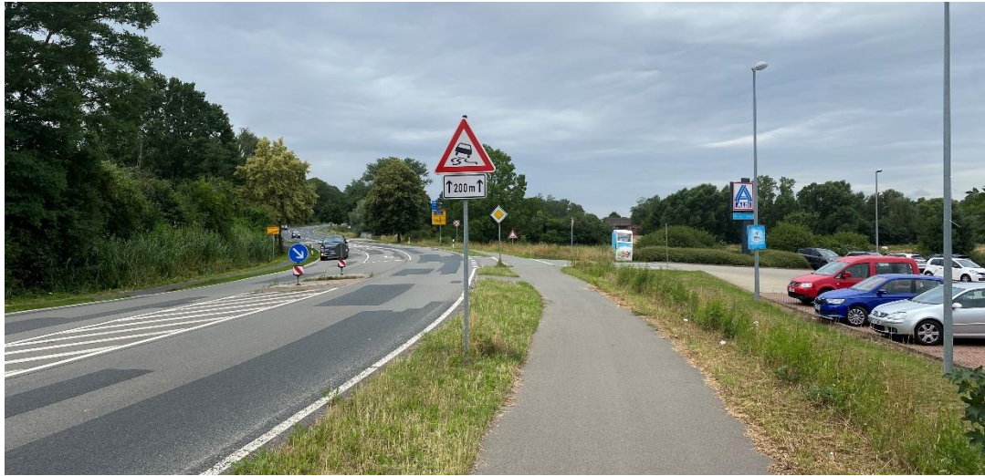
Abbildung 3: Zufahrt zum Vorhabengrundstück über die Berliner Straße
