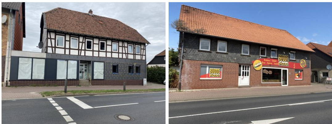
Abbildung 11: Leerstände an der Berliner Straße 58 (links) und 72
