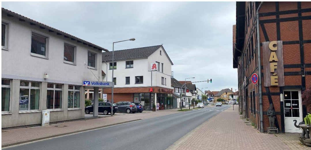
Abbildung 13: Blick entlang der Berliner Straße in Richtung Süden
