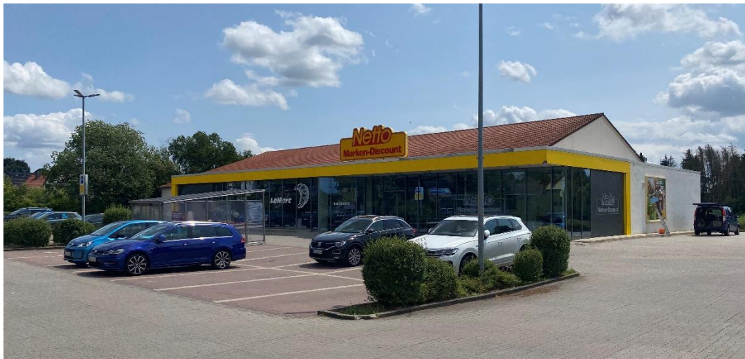
Abbildung 8: Netto-Markt an der Straße ‚Alte Berliner Straße‘
