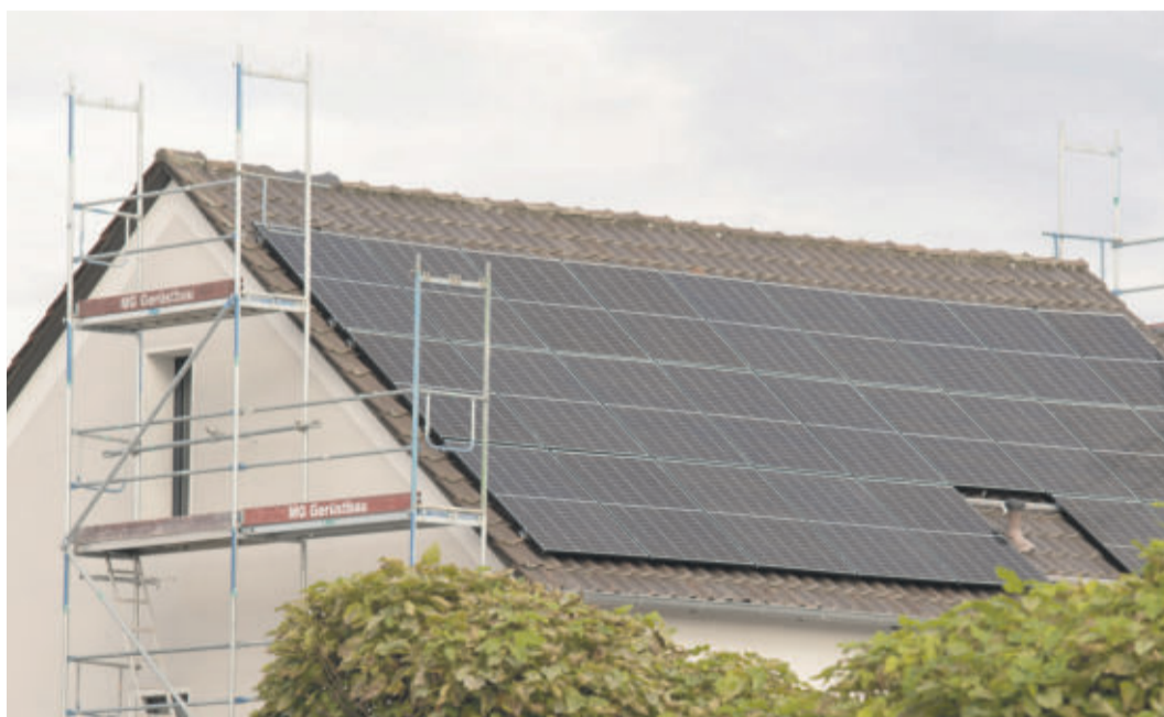
Foto: © BE Schunter Kürzlich errichtete PV-Anlage in Lehre
